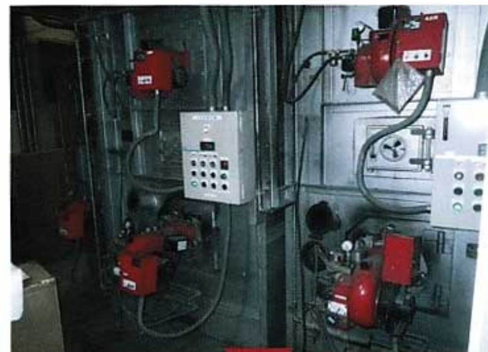
バーナ施工前
